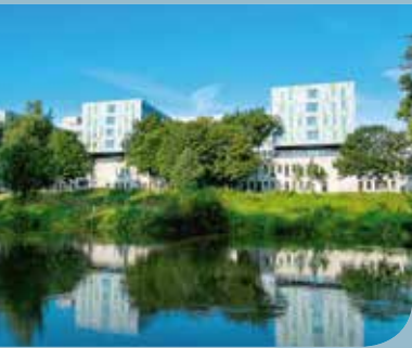
Mit Flussblick: Im neuen KRH Siloah-Oststadt-Heidehaus sind alle Patientenzimmer zur Ihme ausgerichtet.
